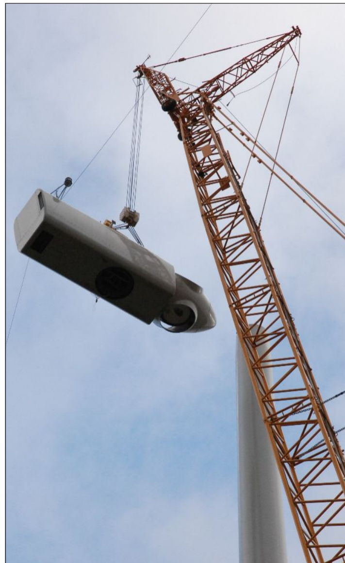
Beeindruckendes Schauspiel: Ein 130 Meter hoher Kran hievt die 89 Tonnen schwere Gondel der Windturbine Nummer 1 auf Bolder-Biert in luftige Höhe.
