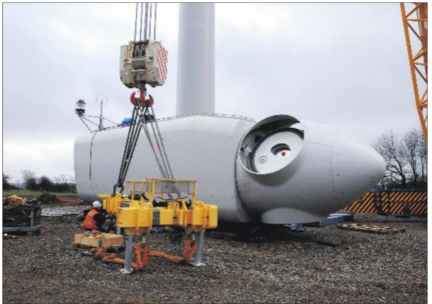
Auf der Hochebene von Bolder-Biert nahe Mürringen entsteht zurzeit der künftige Windpark der Gemeinde Büllingen. Als Bauherr tritt der Energiekonzern Electrabel auf. Unser Bild zeigt die 10 x 3,40 x 3,80 Meter große Gondel der Windturbine Nummer 1.
