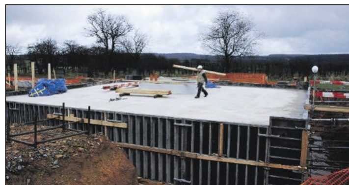
Sorgen bereitet dem Bauherrn Electrabel wegen möglicher Fröste das Gießen des Betonfundamente für die Windkraftanlagen.
